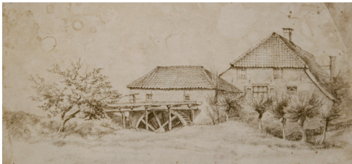
Afbeelding 2: Uitsnede van een tekening uit 1857 van Maria Vos van de molen van Hooijer aan de Gielenbeek te Oosterbeek. In 2008 werd hier een vrij constante afvoer gemeten van vijf liter per seconde, veel te weinig om deze molen aan te drijven: bij een overstorthoogte van drie meter bedroeg het netto-vermogen misschien 100 watt, voldoende voor een gloeilampje.
